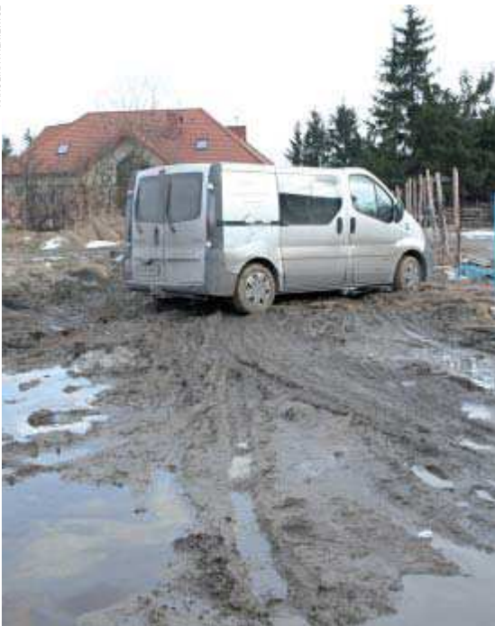
W uliczce wjazdu odmawiają służby komunalne, kosze ze śmieciami trzeba ciągnąć 100 metrów do utwardzonej drogi
